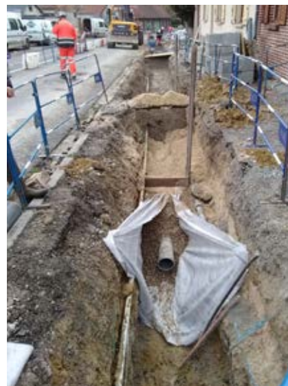
Travaux rue du 31 août 1944 à Pont-Noyelle
