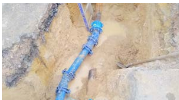
Raccordement du nouveau réseau
