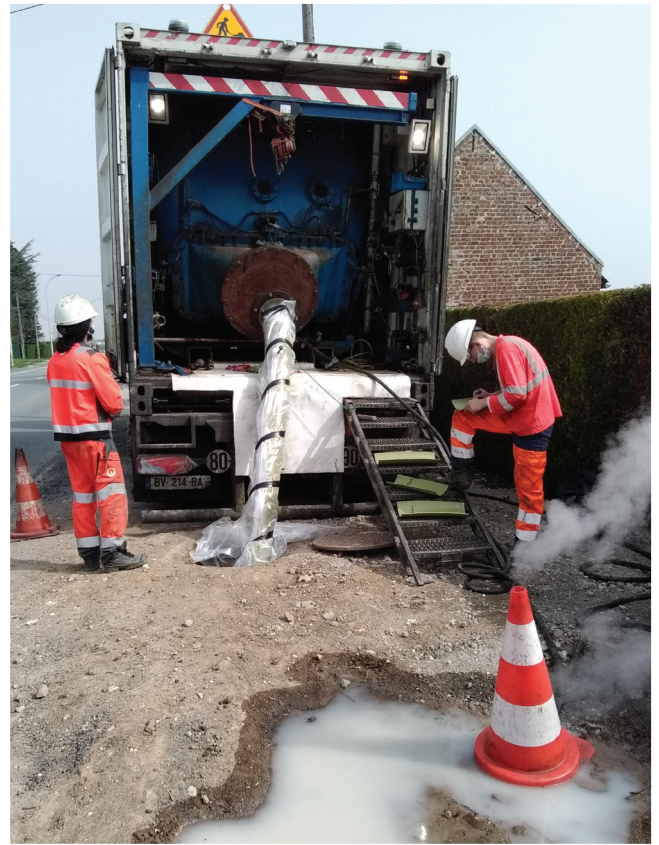
Travaux d'assainissement sur la RD 1029
