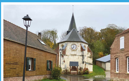
Bresle, enfouissement des réseaux
