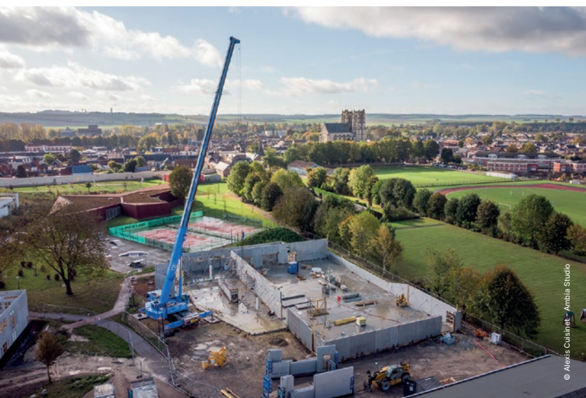
Chantier du futur gymnase dans l'enclos de l'Abbaye à Corbie
